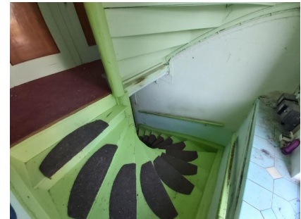
die Treppe zum Obergeschoss
